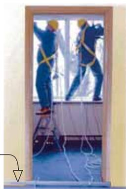
Doit être montée en position horizontale sur le sol
